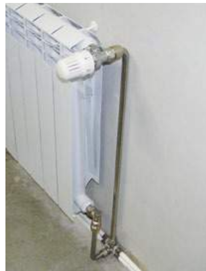
Рис. 17 Подключение радиатора с использованием комплекта VT.045
