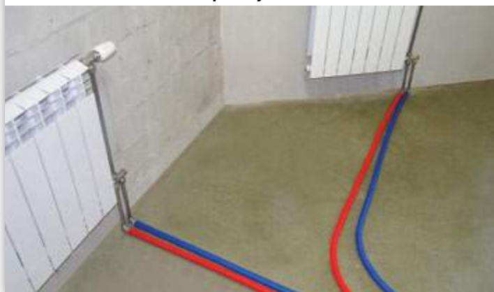
Рис. 20 Подключение радиаторов при коллекторно-лучевой схеме
