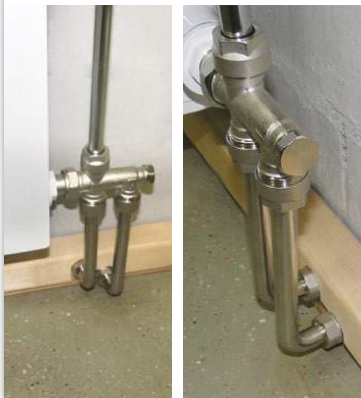
Рис. 15 Плинтус из деревянного уголка (стоимость плинтуса с учетом покраски 180 руб. за погонный метр)
