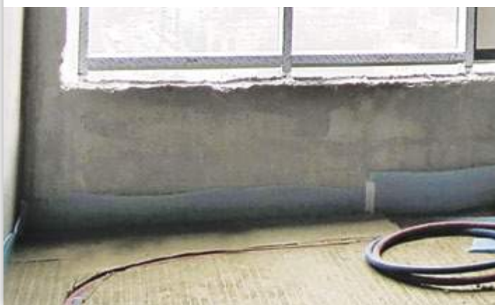
Рис. 6 Прокладка трубопроводов в штробах шумоизоляционных плит
