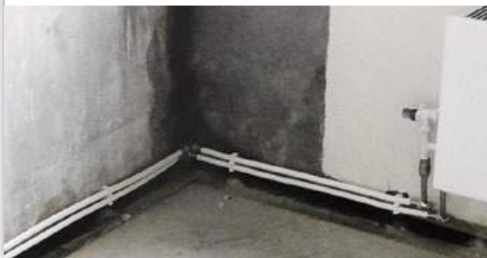
Рис. 10 Плинтусная прокладка трубопроводов
