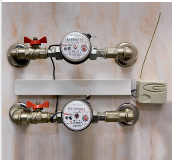
Рис. 7 Подключение приборов учета к преобразователю VT.D100
