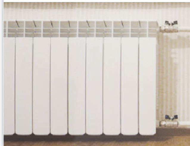
Рис. 1 Подключение радиатора с помощью шаровых кранов
