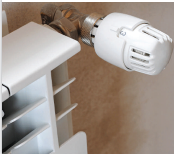
Рис. 6 Установка термостатического клапана на радиаторе
