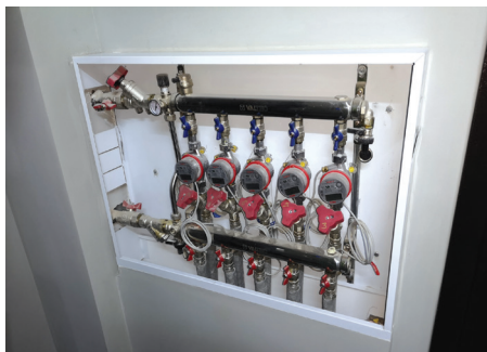
Этажный распределительный узел системы отопления VT.GPR с балансировочным и перепускным клапаном.
